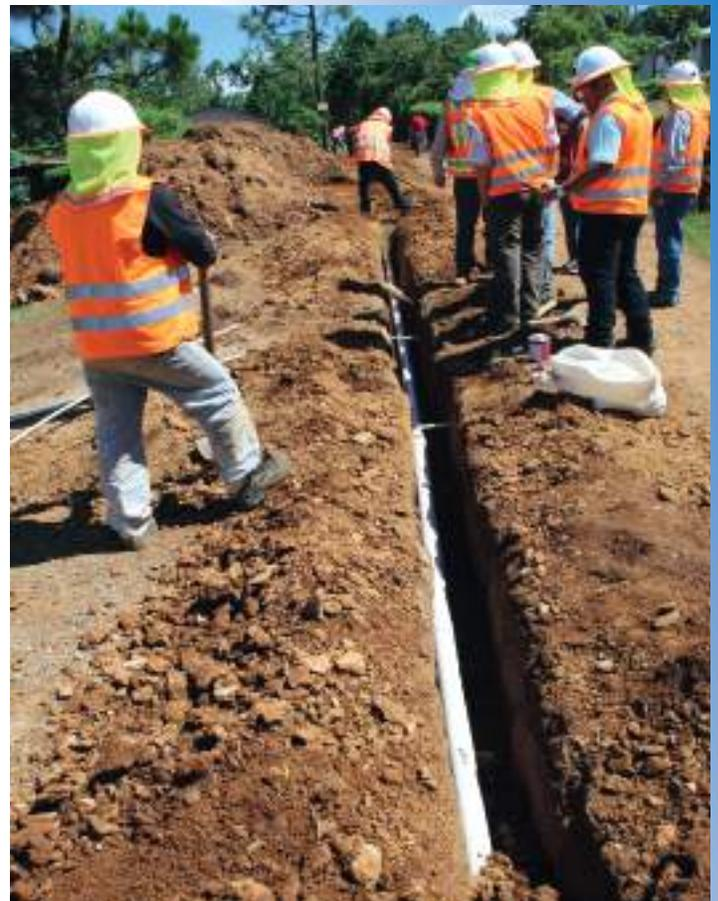
A mediados de 2019 avanzaba con paso firme la colocación de tubería para distribuir el agua.
