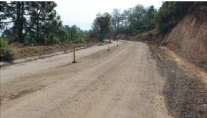
**Los taludes a ambos lados fueron reconfigurados, para tener un mejor control sobre la escorrentía de lluvia.**
