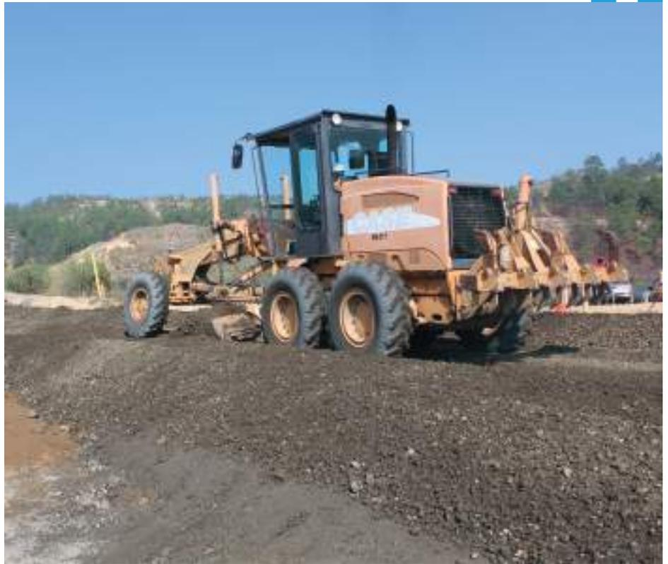
La maquinaria acondiciona la base sobre la cual se colocará el asfalto de la carretera.
