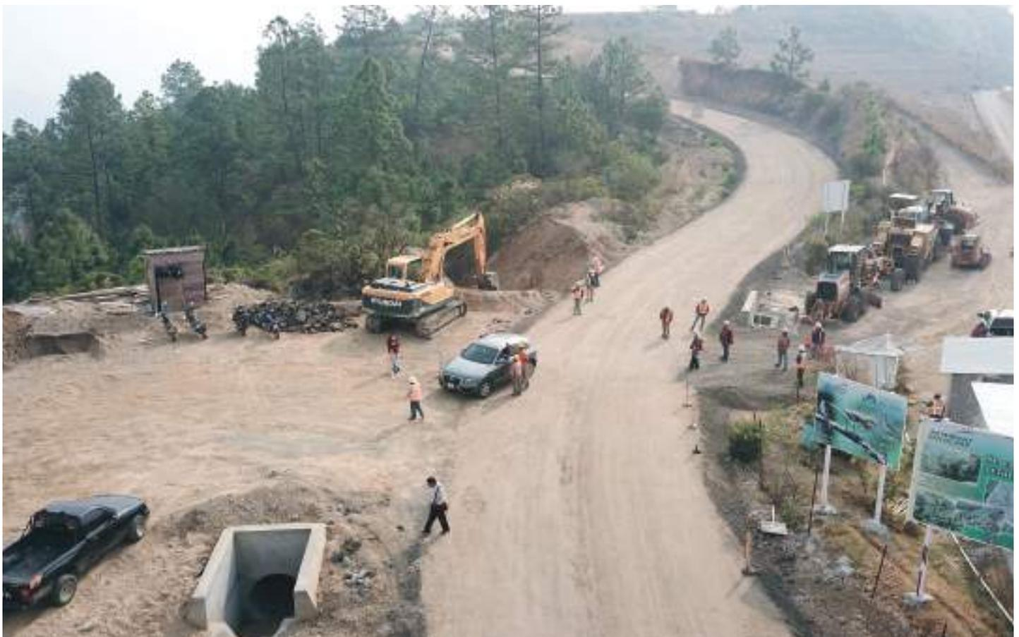
En Cuatro Caminos se mantiene una intensa actividad para acondicionar el terreno sobre el que se colocará el asfalto. Aquí se ven las estructuras para impedir erosiones y socavamientos.
