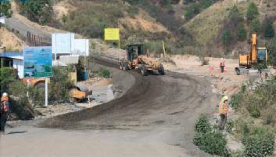
**A finales de abril de 2020, los operarios mantenían un trabajo intenso para asegurar la base sobre la que se coloca el asfalto.**
