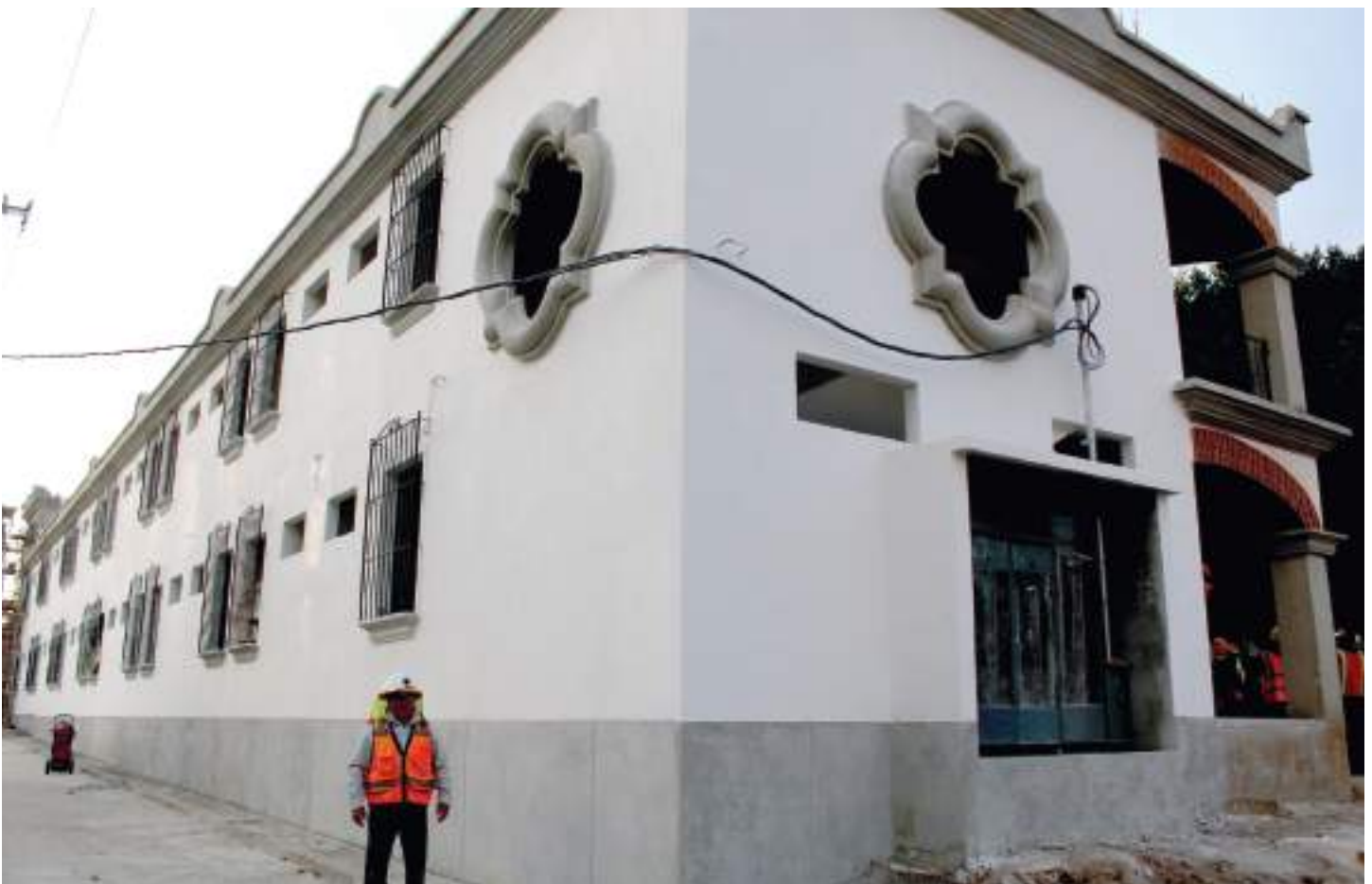
Parte trasera del edificio. El ingeniero Fernando Gómez muestra el avance de la obra.
