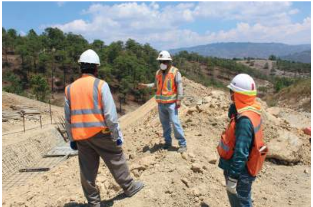
El ingeniero Osiel Orozco da indicaciones a los operarios sobre cómo realizar los trabajos de la construcción de un tramo del canal antierosión.
