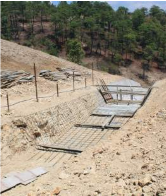
En este lugar se construye la estructura que une los canales que traen el agua para enviarla a la quebrada natural.
