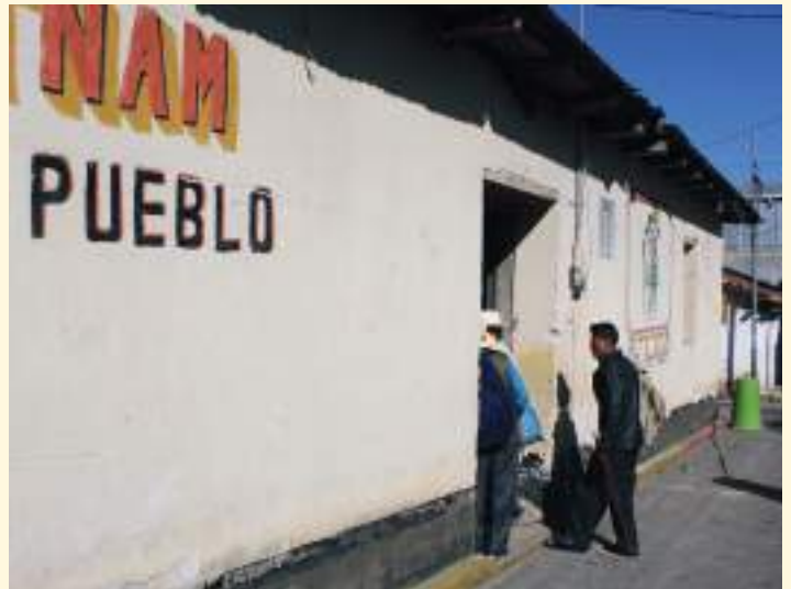
La antigua "Casa del Pueblo" fue sustituida por la nueva obra.
