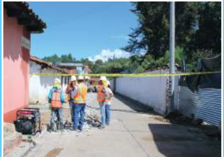
La instalación del servicio de agua potable en el casco urbano de Sipacapa está muy cerca de ser finalizada.
