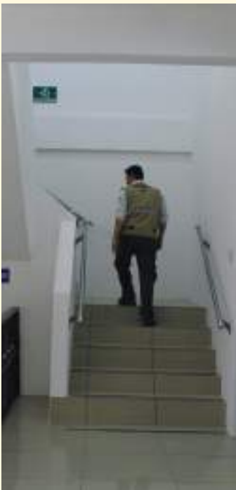
Las gradas que comunican al segundo con el tercer piso.
