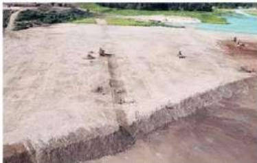
En los últimos días se ha acelerado la colocación de suelos para cubrir el terreno.
