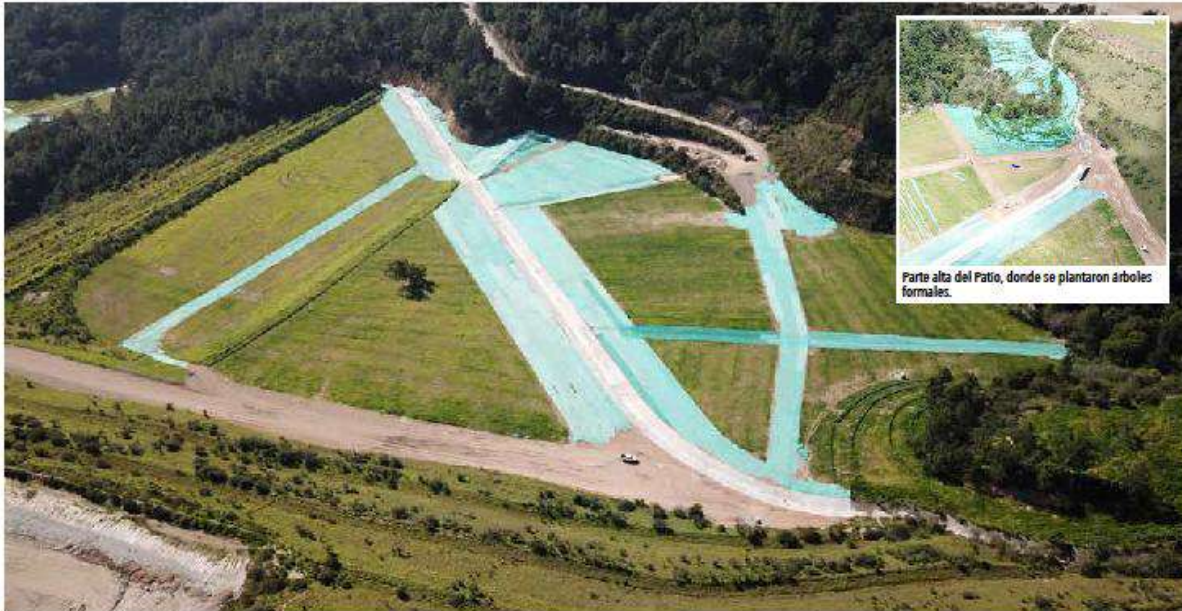
Vista aérea de la plataforma del Patio Mina UG.
