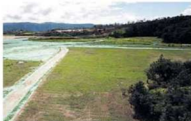
Imagen de uno de los canales para controlar el agua de lluvia.
