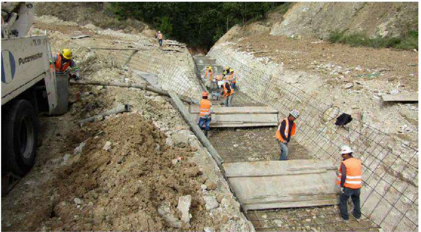
Los canales que controlarán el agua del Tajo Marlin y La Escombrera se construyen con materiales de alta resistencia.
