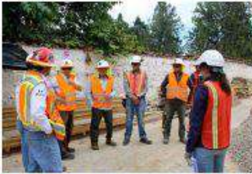
Supervisando las obras del edificio comercial - municipal en el casco urbano de Sipacapa.
