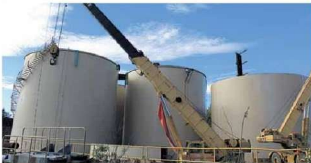
Durante el proceso de desmontaje se siguieron normas estrictas de seguridad.
