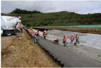
En el Patio Mina UG se construyó una estructura de concreto que dirigirá la lluvia hacia una quebrada que se une con La Represa.
