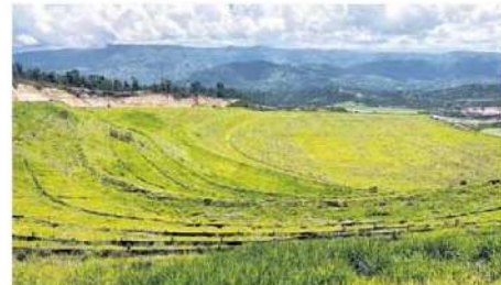
La reforestación de La Escombrera ya se inició, una vez que la grama quedó consolidada.
