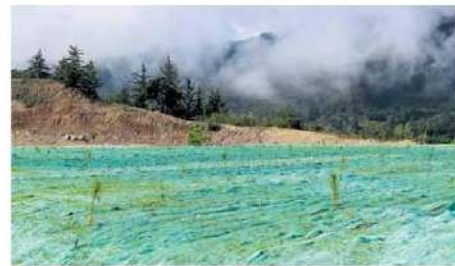
El Patio de Trituración es otro sitio donde se inició la siembra de árboles.
