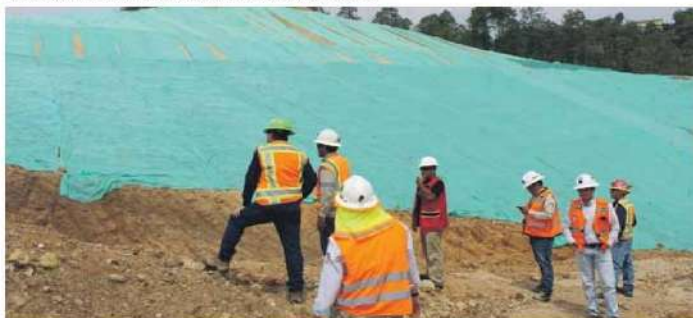
En el sitio de la Bodega de Núcleos también se inició la hidrosiembra.
