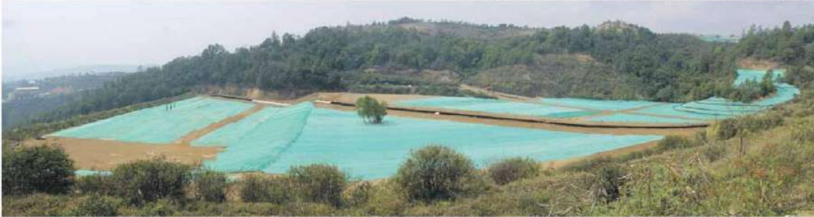
El geotextil para cubrir la revegetación en el patio y los portales de la Mina UG (a la derecha) se ve en la lejanía.
