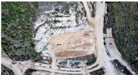
La Catedral o almacén de colas filtradas está en proceso de recubrimiento con material apto para la siembra de plantas.
