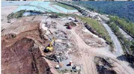
La demolición de la Planta de Tratamiento de Aguas Industriales está cerca de concluir, para iniciar la revegetación.
