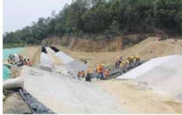
Para proteger plataformas del Patio Mina UG, los canales conducirán el agua hacia la represa.
