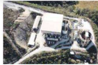
De la planta de filtros también ya se inició el desmontaje de equipo y maquinaria.
