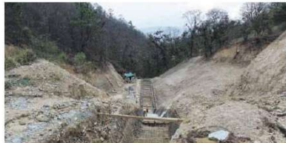
Parte baja del canal de Cochise en construcción.
