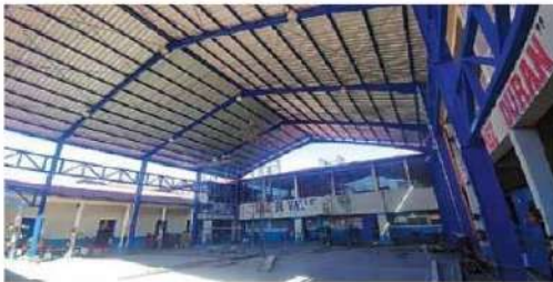
Con el cambio de techo, hubo una mejora ostensible para fortalecer la seguridad de los alumnos.
