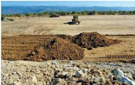
Operarios del Departamento de Mina Superficie trabajan a ritmo acelerado en la recomposición del Patio Mina UG.
