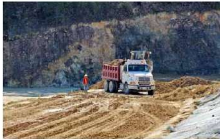
La colocación de materiales para la revegetación es un paso indispensable en el fortalecimiento del ecosistema.
