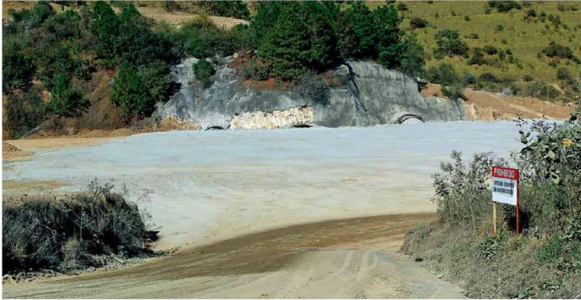
La entrada a los túneles quedará totalmente cubierta al finalizar la cobertura con materiales aptos para la revegetación.
