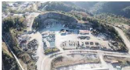
El Patio de Trituración se utiliza ahora como parqueo.
