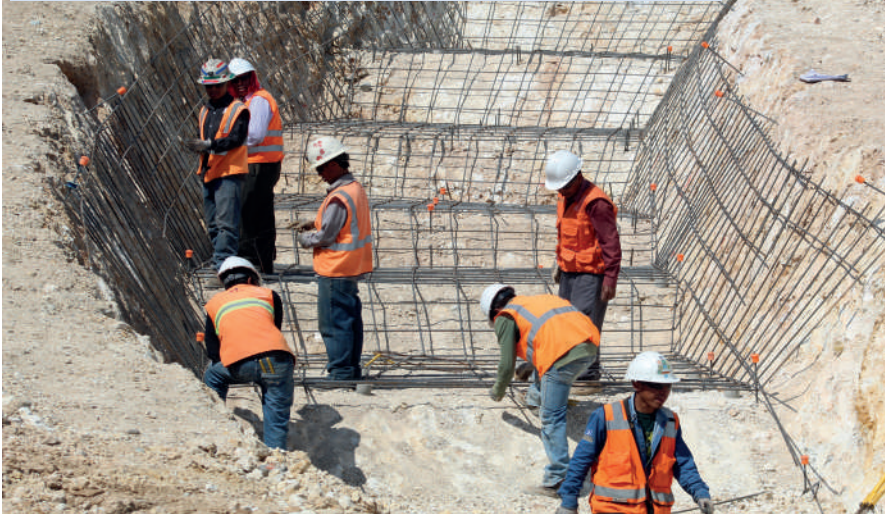
Operarios trabajan en la elaboración de la estructura metálica que dará resistencia al canal de concreto.
