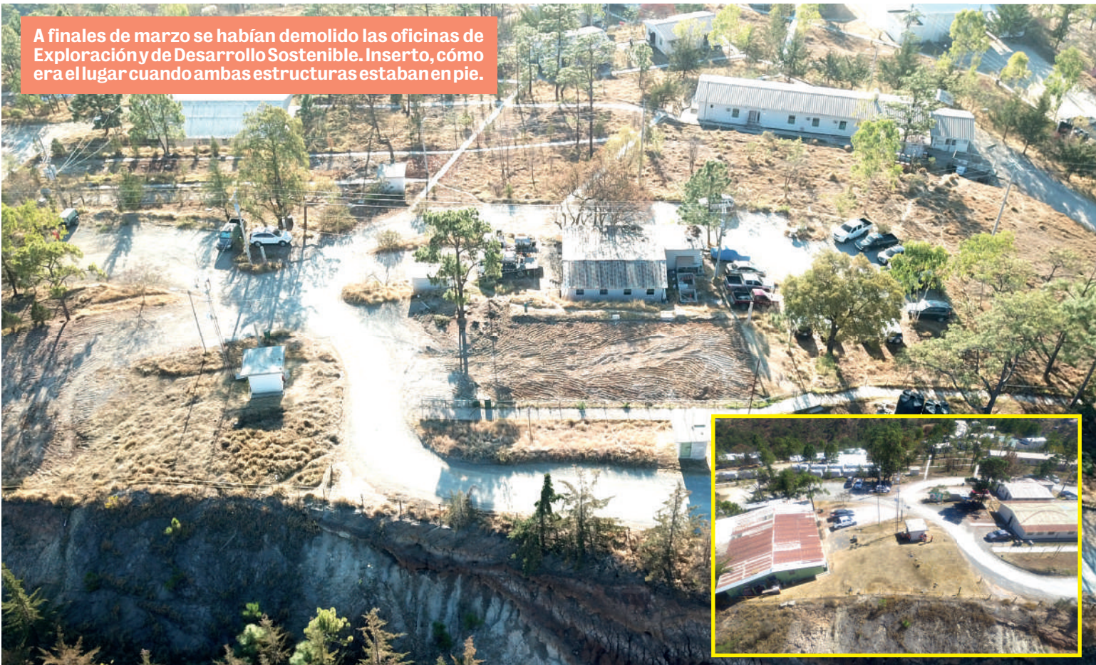
Imagen del desmontaje de bodegas y de la planta de aguas industriales a finales de marzo. Inserto, ambas estructuras en operaciones.
