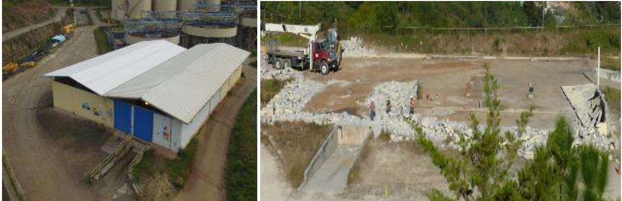
Ilustración 6. Proceso de desmantelamiento bodega de químicos
