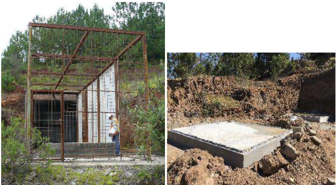
Ilustración 17. Chimenea 1 y 2, Delmy.
