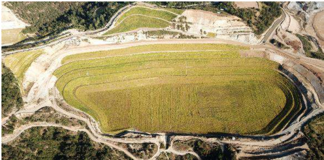
Ilustración 1. Avances de la recuperación del tajo y escombrera.
