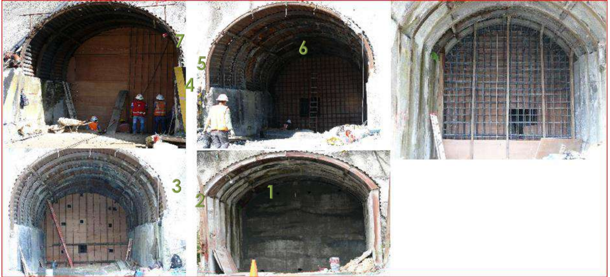
Ilustración 4. Cierre Portal Marlin
