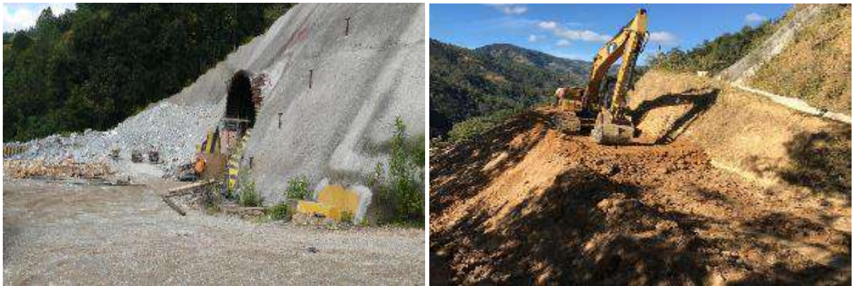
Ilustración 5. Proceso de colocación material en Portal West Vero
