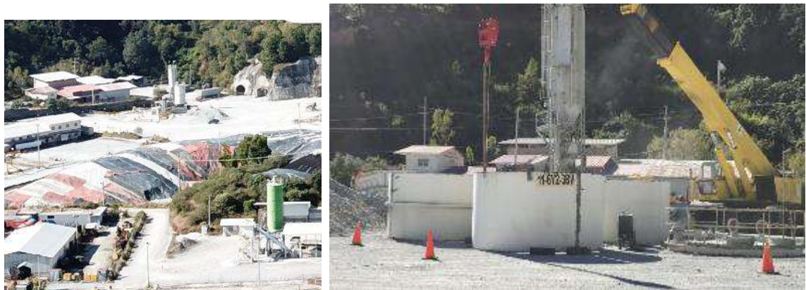
Ilustración 9. Desmontaje silos verticales área Batch y Shotcrete
