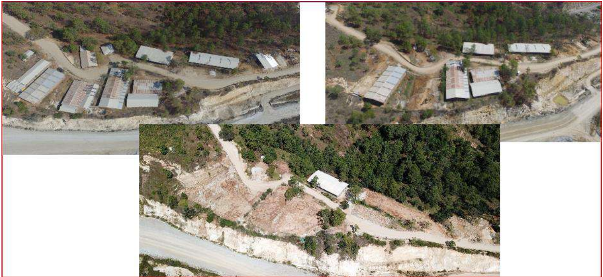
Ilustración 10. Desmantelamiento bodegas de núcleos
