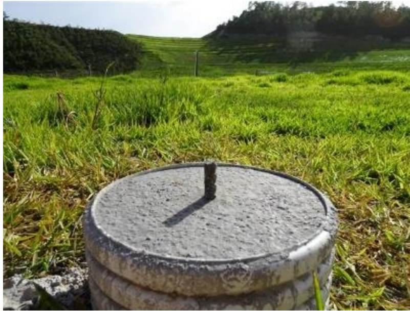
Ilustración 2. Bases de concreto para monitoreo en Escombrera.
