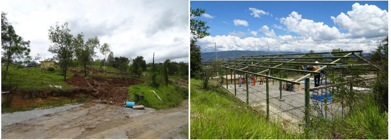
Ilustración 8. Desmantelamiento Oficinas Ambiente y Vivero
