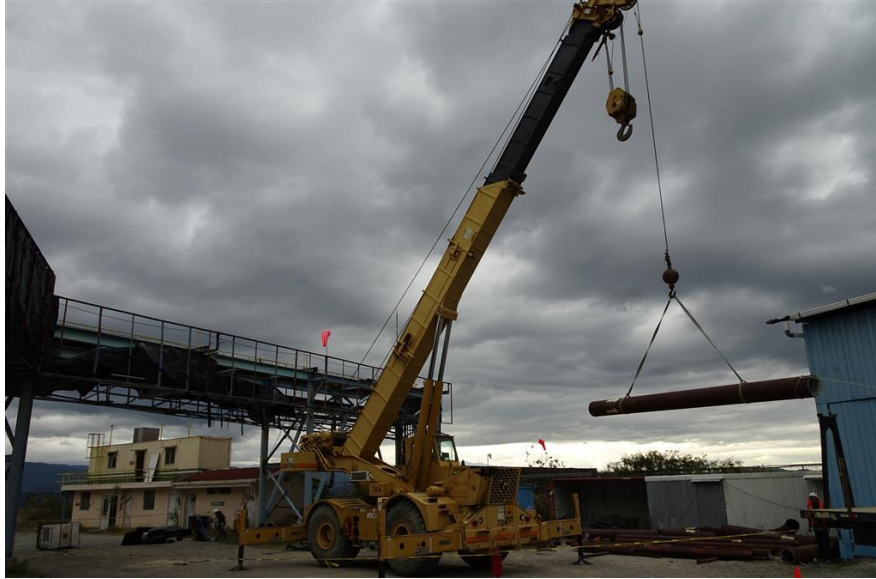
Ilustración 10. Desmontaje tuberías en procesos
