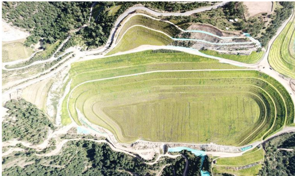
Ilustración 1. Avances de la recuperación del tajo y escombrera.
