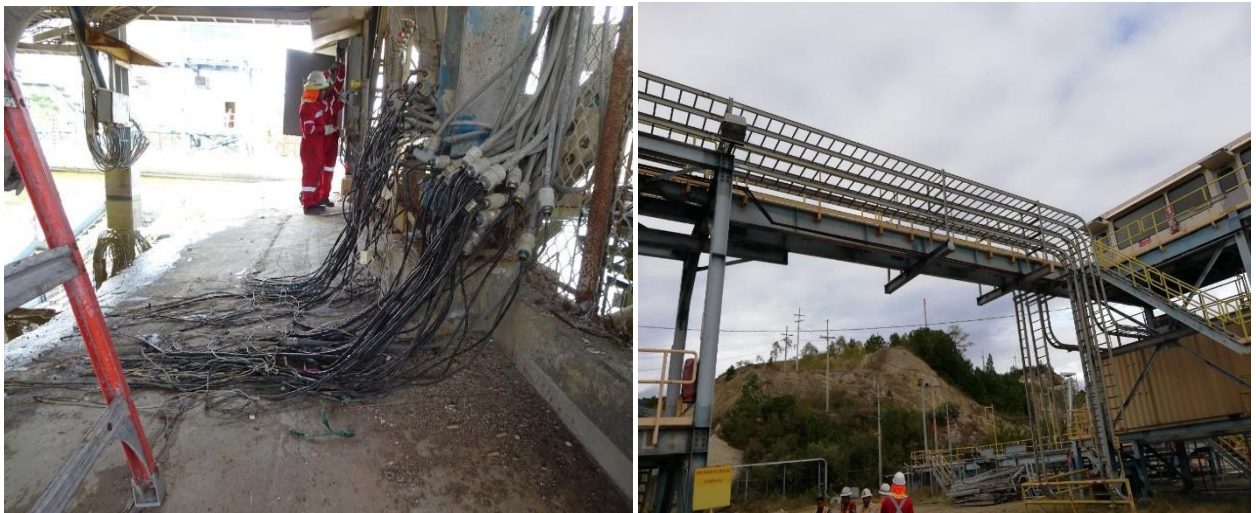
Ilustración 13. Desmantelamiento cableado en Procesos
