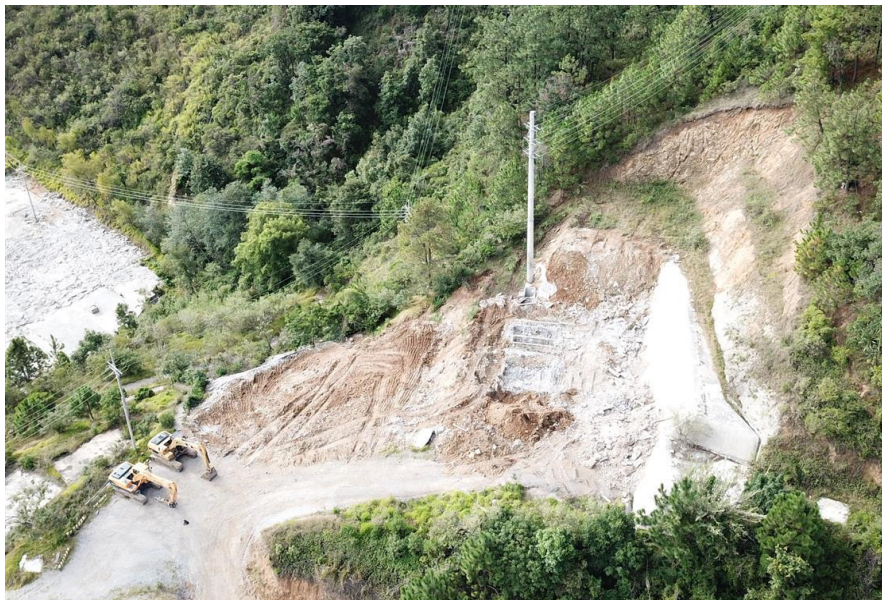
Ilustración 11. Desmantelamiento sub estación eléctrica #2 Mina Subterránea
