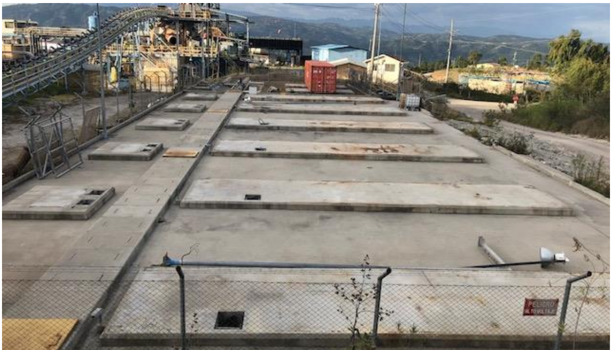
Ilustración 7. Desmantelamiento Generadores Eléctricos Procesos.
