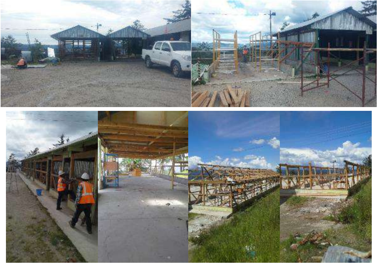
Ilustración 7. Proceso de desmantelamiento de las bodegas 2 a la 7.
