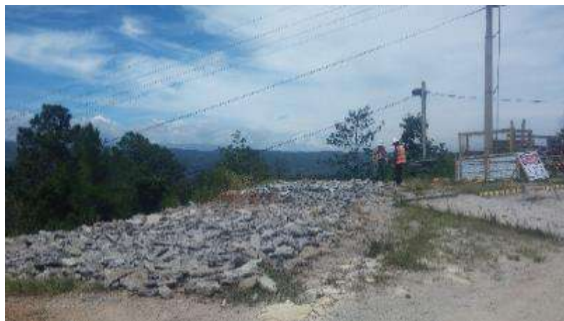
Ilustración 8. Remoción de partes de piso
