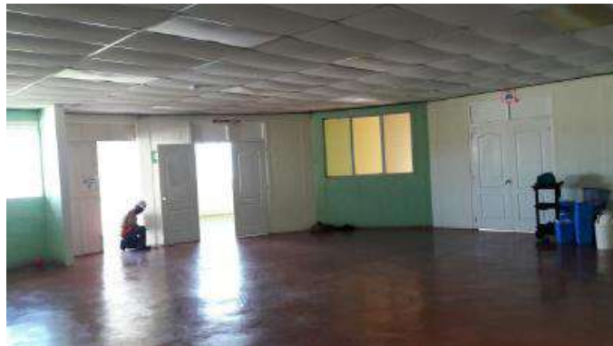
Ilustración 17. Proceso de desmantelamiento de casa cuna.
