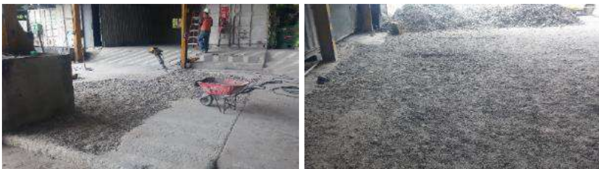
Ilustración 10. Recuperación de piso impactado
