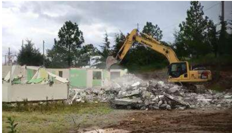
Ilustración 18. Proceso de demolición de casa cuna
