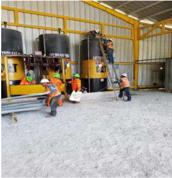
Ilustración 13. Limpieza e inicio de desmantelamiento DUMAS UG
