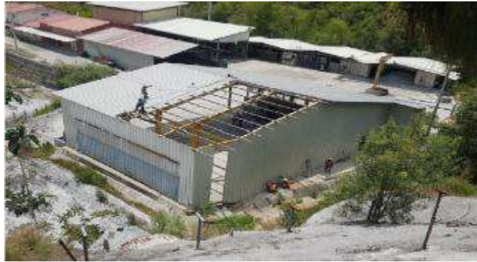
Ilustración 14. Desmantelamiento DUMAS UG.
