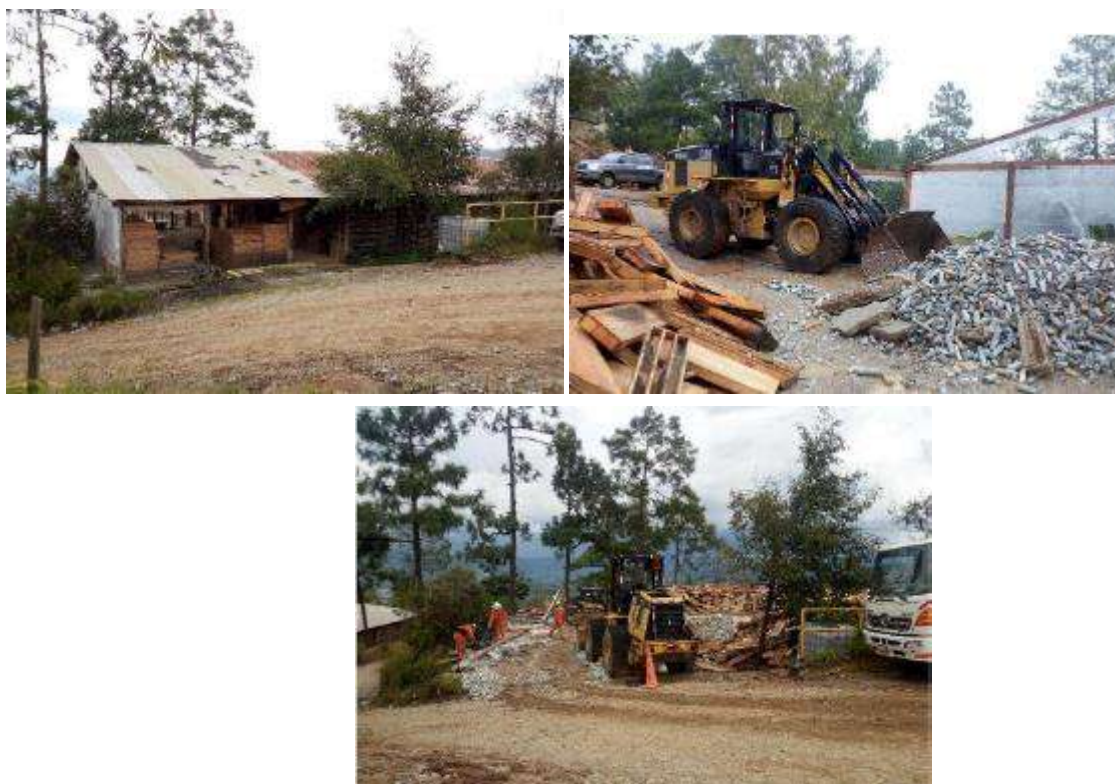
Ilustración 19. Demolición bodega núcleos.
