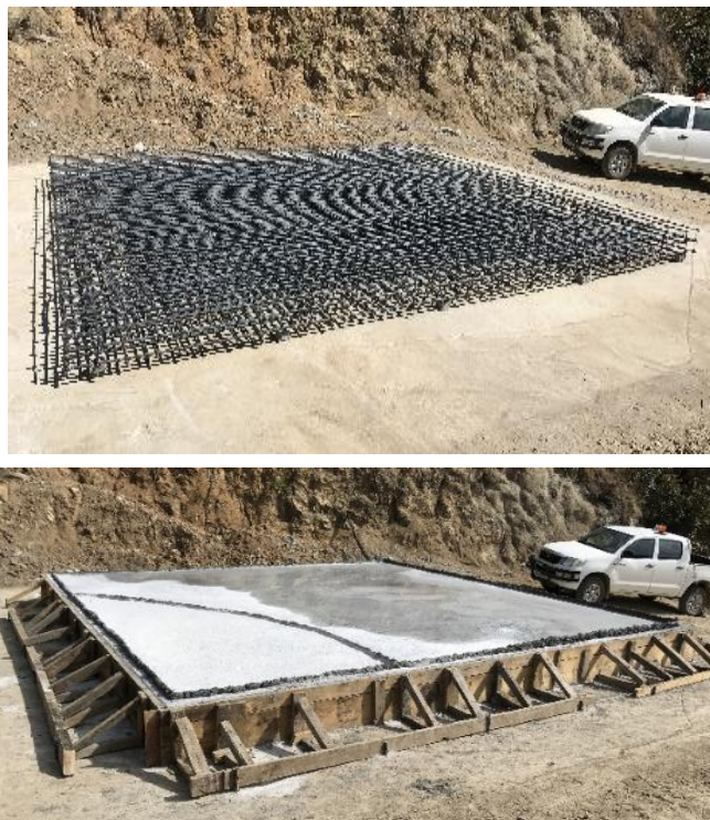
Ilustración 14. Chimenea 9 Alimak West Vero.
