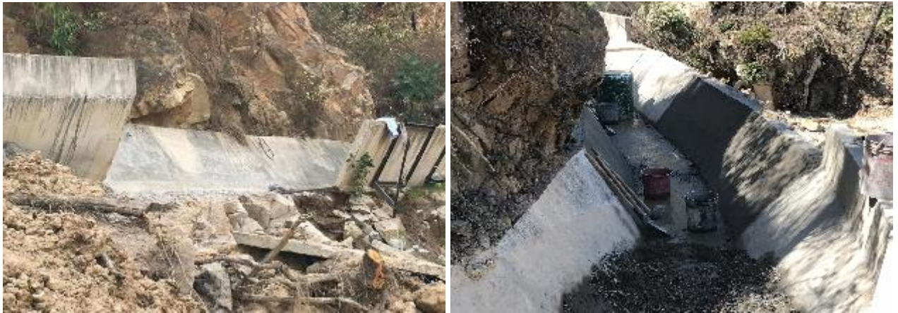
Ilustración 9. Reparación Canal Coronación
