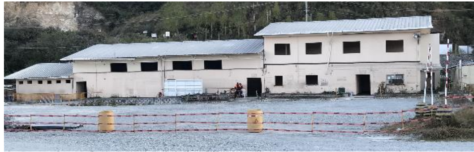
Ilustración 6. Proceso de desmantelamiento Oficinas Mina Subterránea
