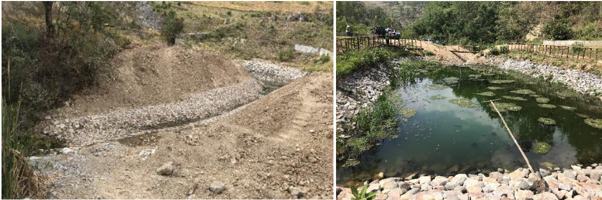
Ilustración 10. Construcción Canal en Seepage
