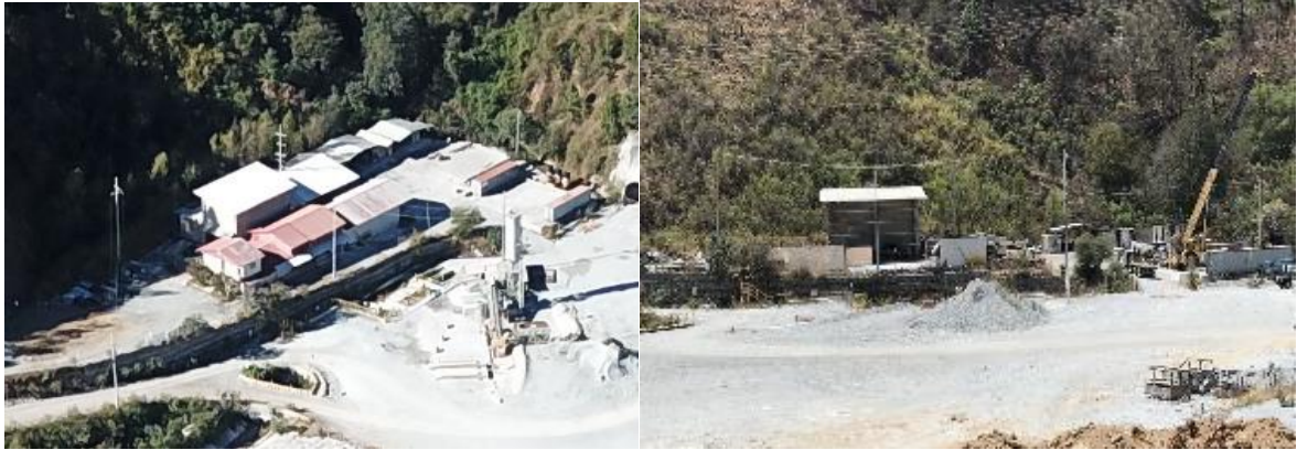
Ilustración 8. Demolición Mantenimiento Mina Subterránea
