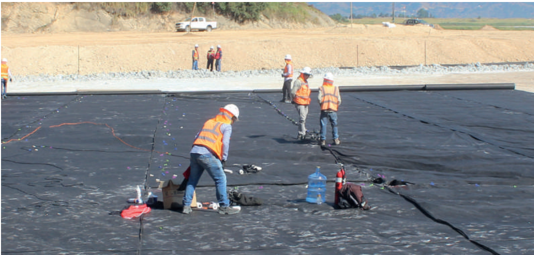
El personal de Obra Civil labora de día y de noche para acelerar el recubrimiento.
