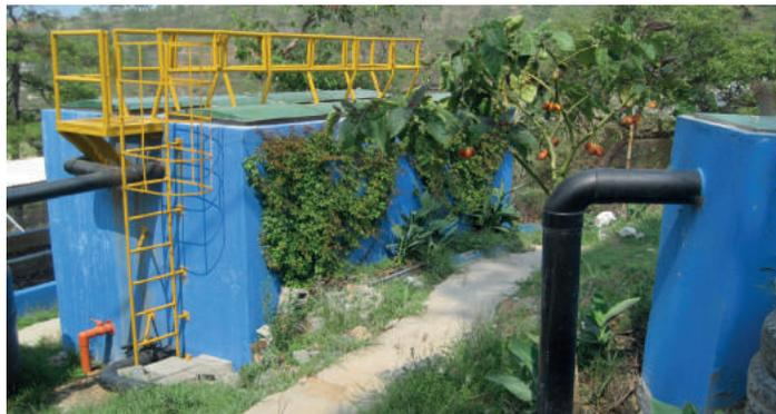
Reactor Anaeróbico de Flujo Ascendente (RAFA).
