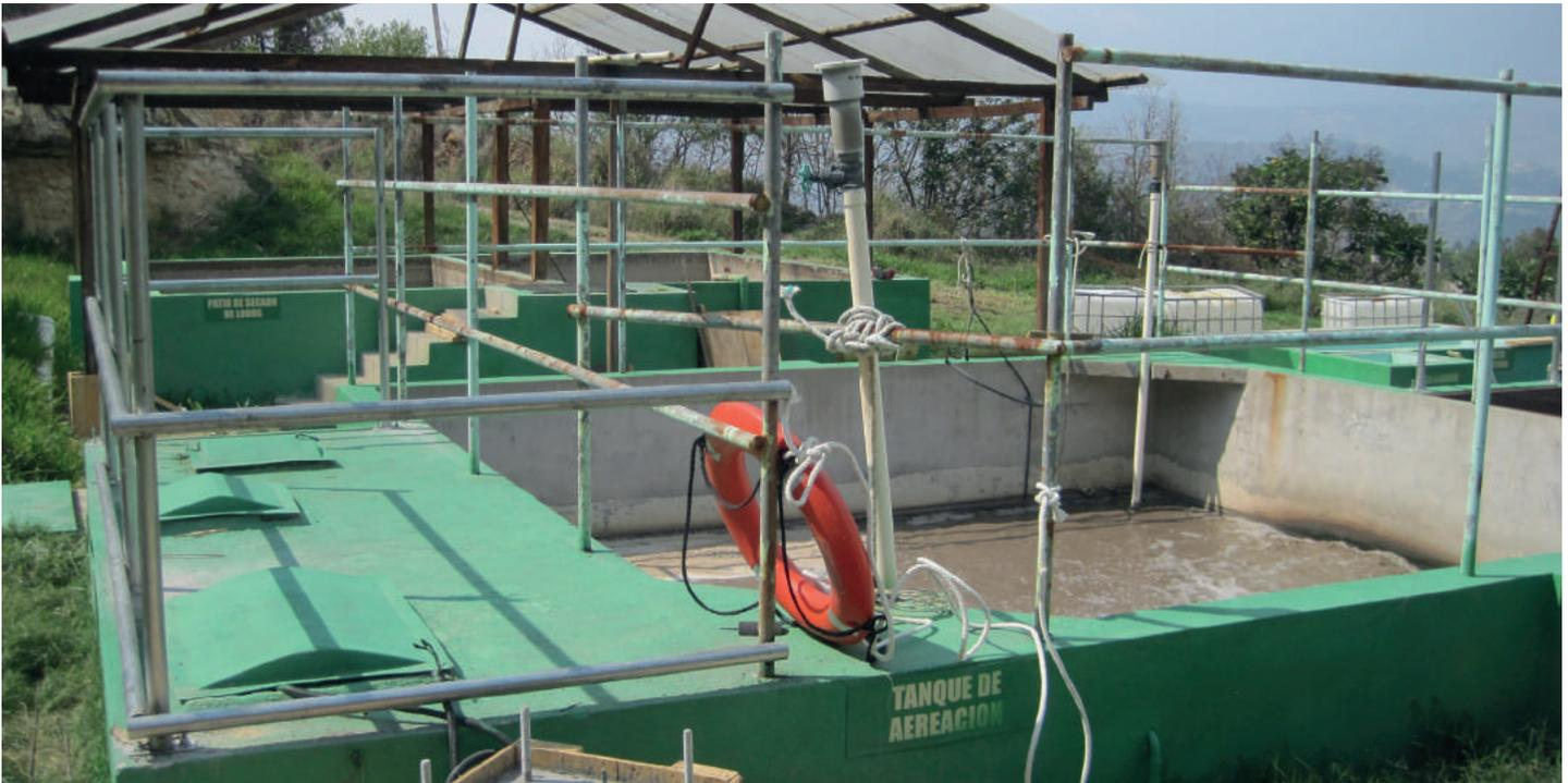
Planta de tratamiento aeróbico de las aguas residuales en la mina.
