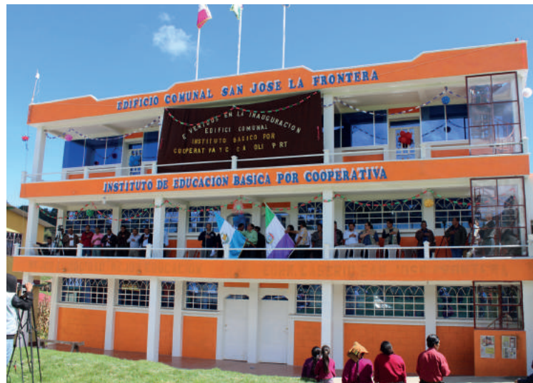
El edificio escolar y de salones comunitarios de San José La Frontera, Comitancillo, es una obra de beneficio comunitario.
