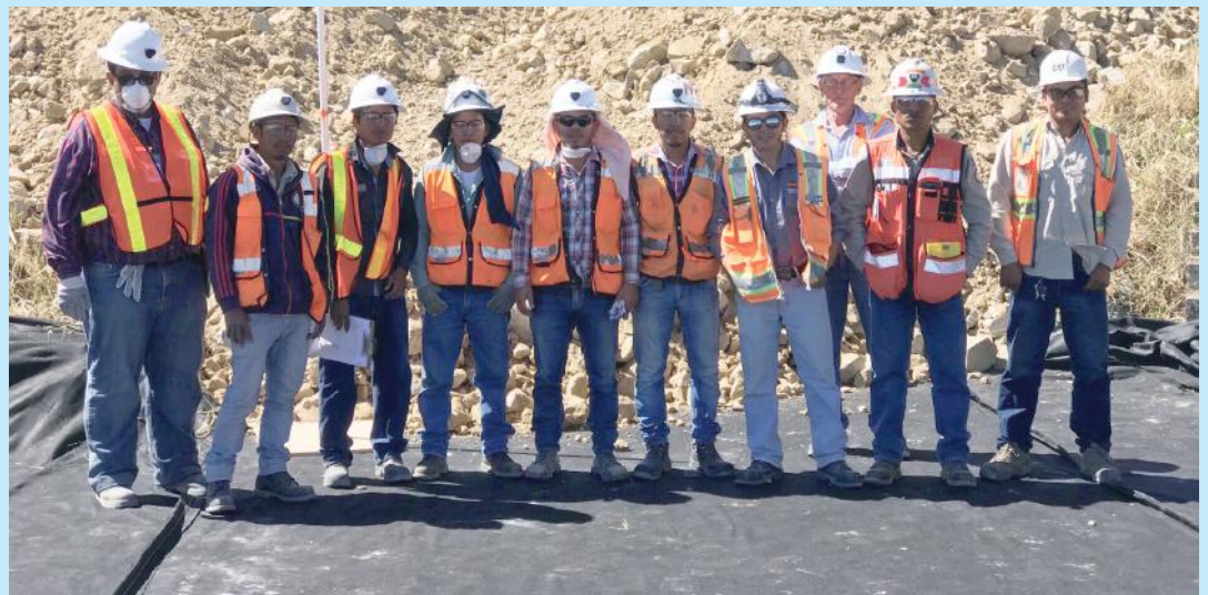
Parte del personal de la empresa contratista a cargo de movilizar materiales.
