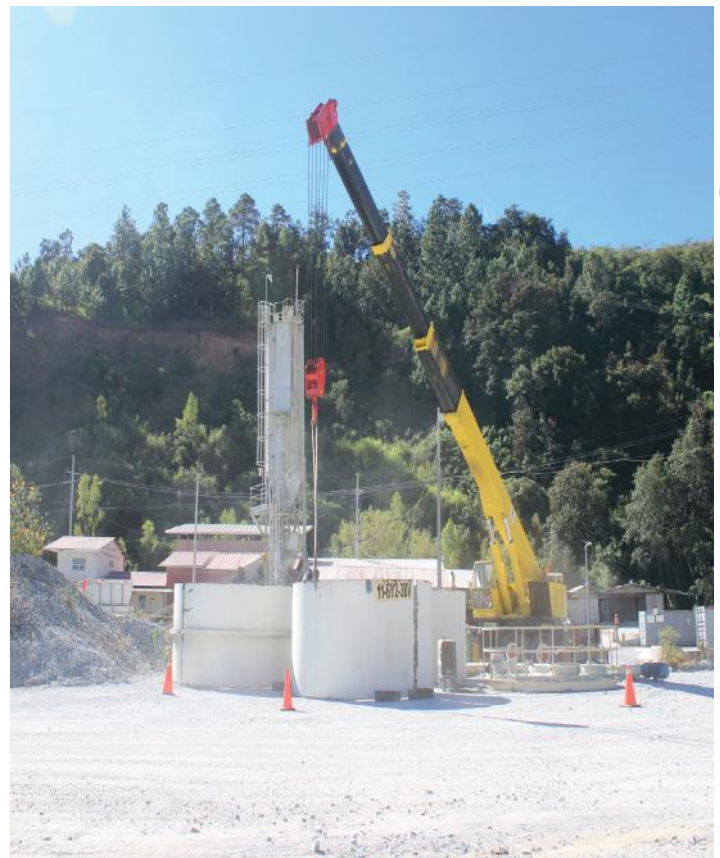
Trabajadores de Cementos Progreso quitaron el silo de la planta de batch (arriba) y de shotcrete (abajo).
