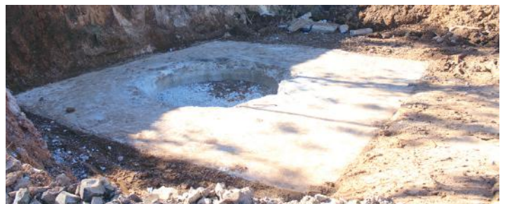
Una chimenea rellena y sellada para evitar intrusiones.
