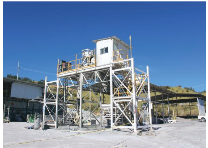
Trabajadores de Cementos Progreso quitaron el silo de la planta de batch (arriba) y de shotcrete (abajo).
