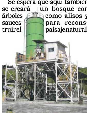
Planta de shotcrete antes de quitar el silo para el cemento.
