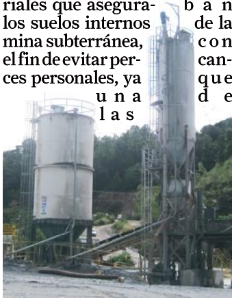
Planta de batch previo a dismantlar el silo.
