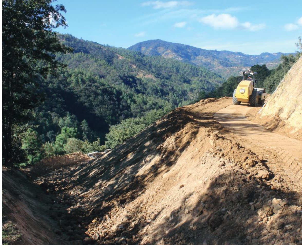
En el lugar donde estuvo el portal West Vero hay un importante avance en su recubrimiento con
