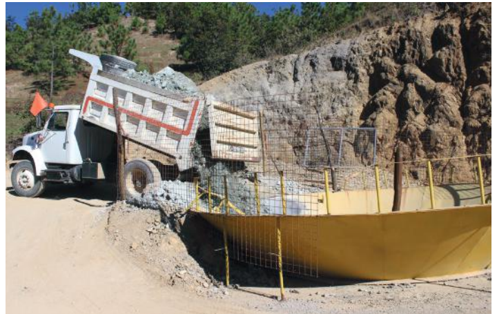
Hay estrictas medidas de seguridad al rellenar chimeneas.
