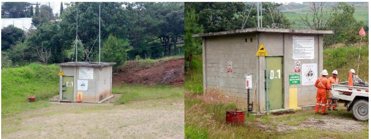
Ilustración 15. Bodegas previas a su desmantelamiento
