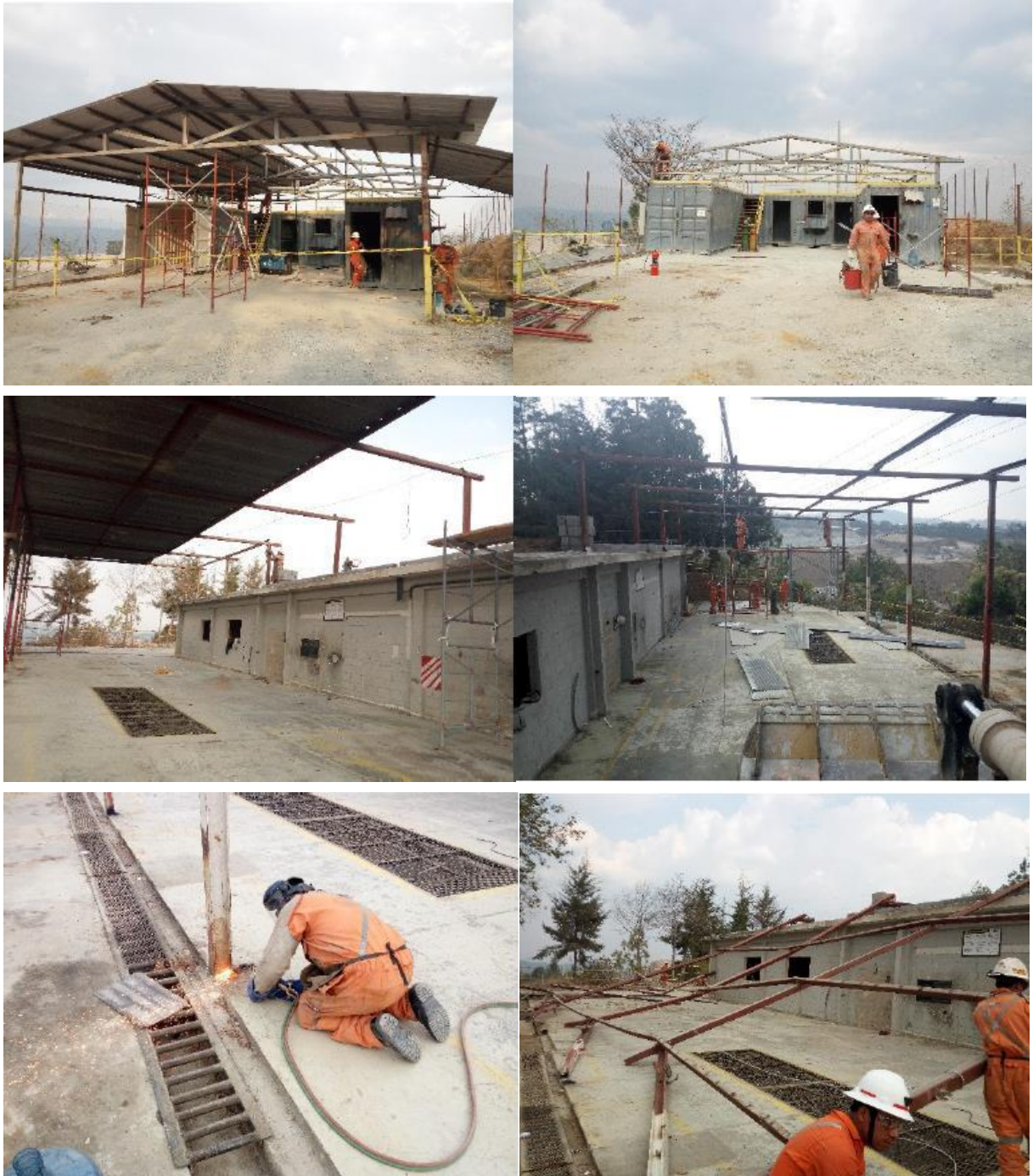
Ilustración 8. Desmontaje y desmantelamiento de EMO y PERFORACIÓN (I)
