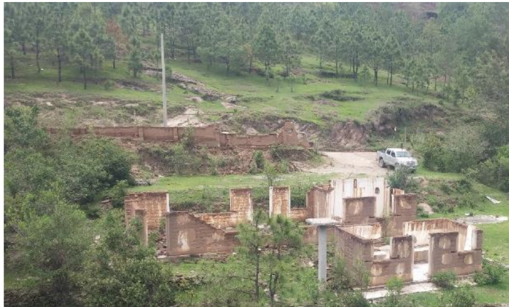
Ilustración 18. Área de demoler
