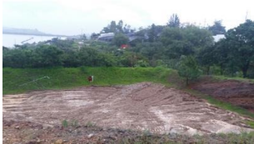
Ilustración 17. Nivelación y conformación de área
