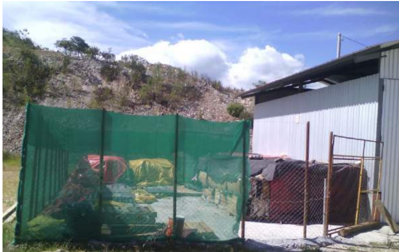
Ilustración 6: Patio de almacenamiento y acopio temporal
