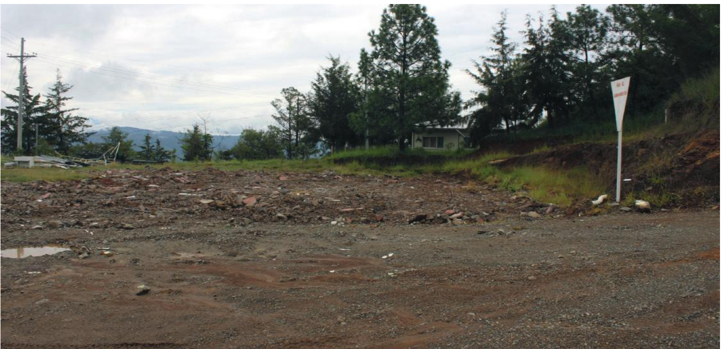
Aquí estuvo la guardería para los niños de las mineras. Fue demolida y en el área se sembrarán plantas gramíneas.
