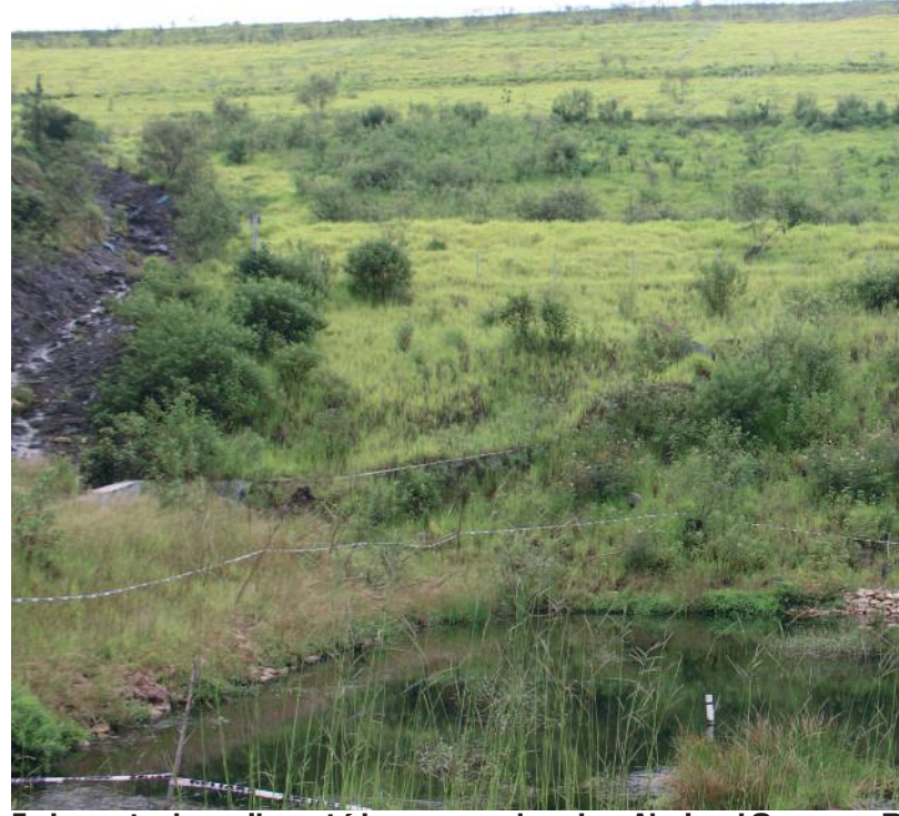
En la parte de arriba está la represa de colas. Abajo, el Seepage Pond .
