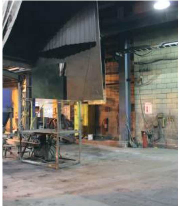
La Planta de Fundición está lista para ser desmontada.
