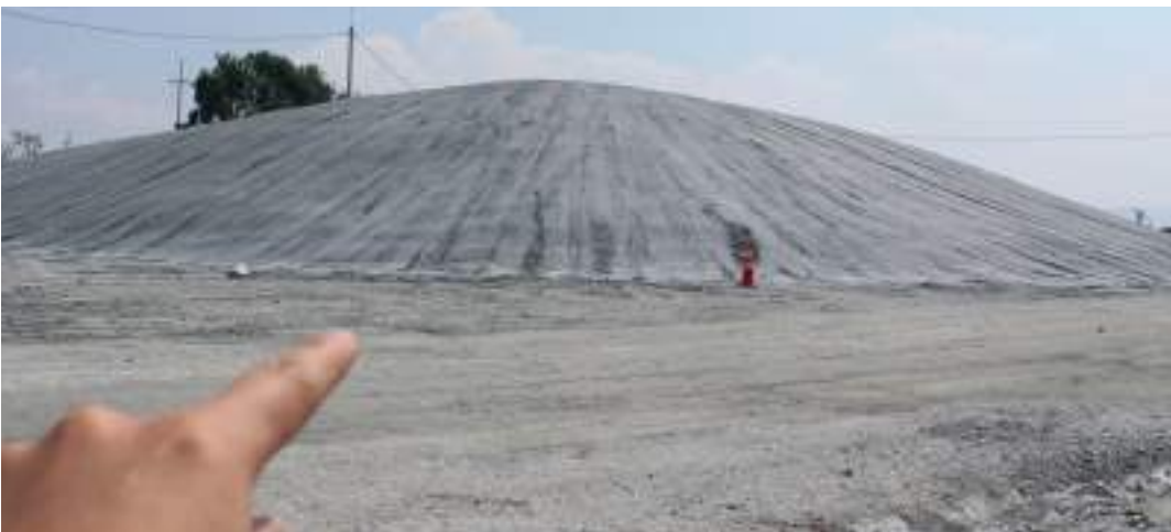
En el patio de la mina subterránea se hace acopio de materiales para la restauración.
