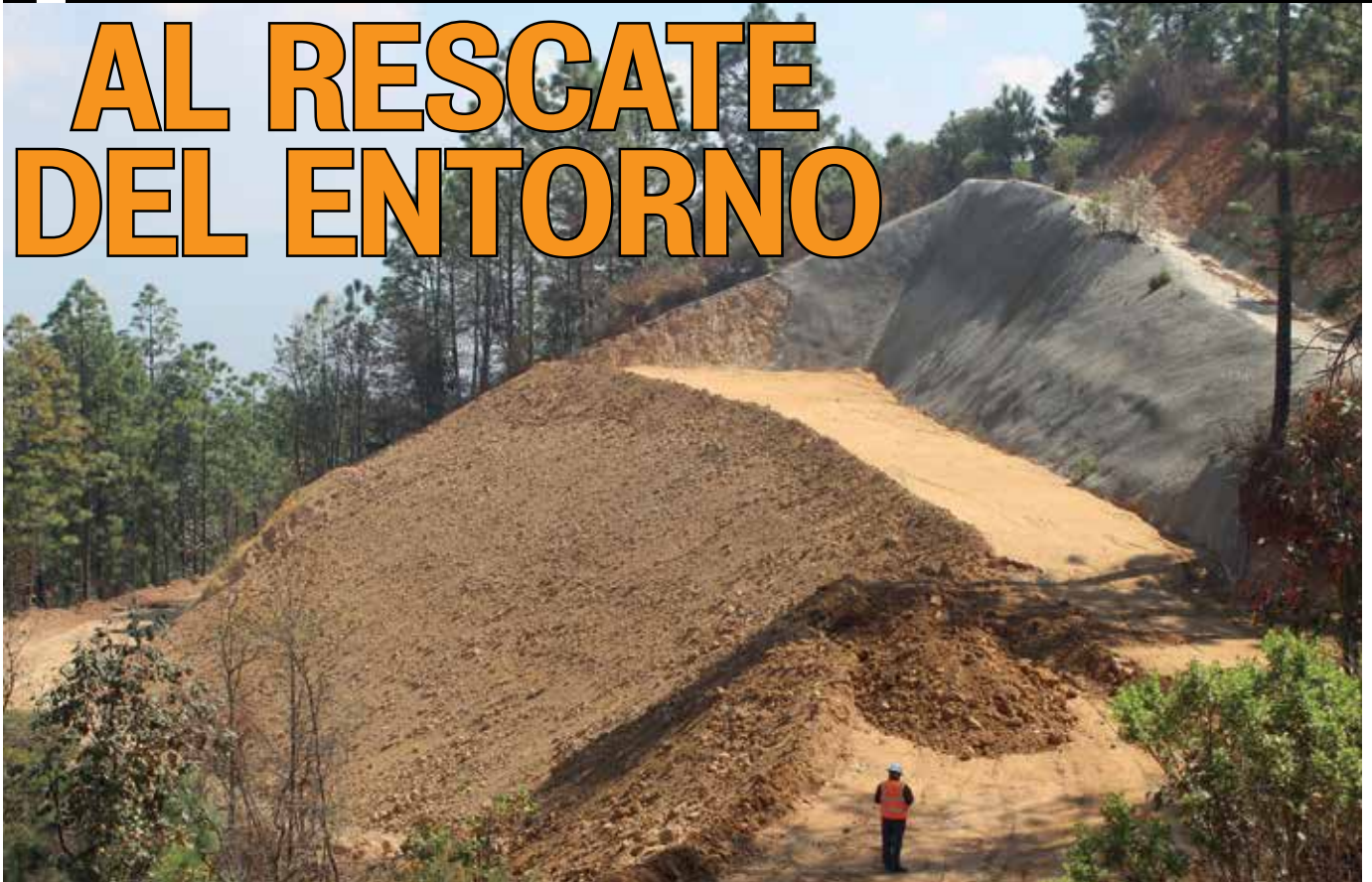
El Portal en el Sector Delmy fue sellado y se trabaja en la restauración del área para proceder a la siembra de gramíneas.
