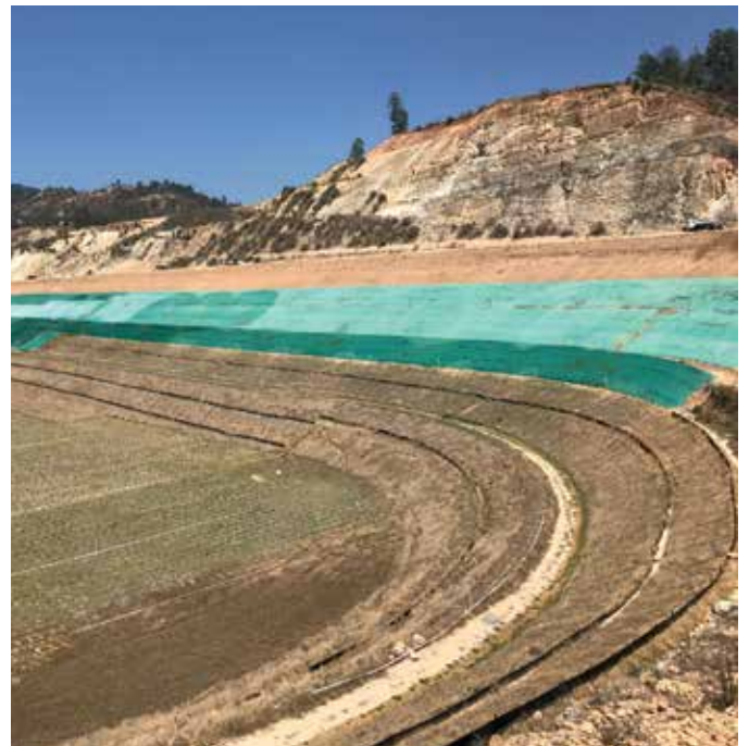
En el Tajo Marlin se avanza con la restauración de taludes.
