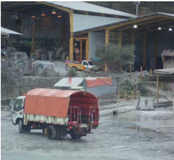
El taller de mantenimiento móvil de la mina subterránea.
