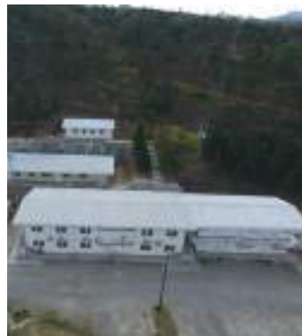
Así era el área de Dumas antes de su demolición.
