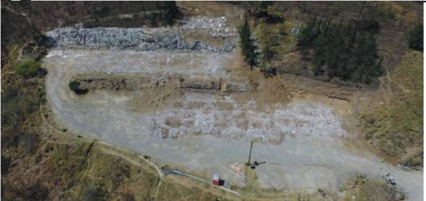
Vista aérea del lugar que ocupó la empresa contratista Dumas Mining, luego del desmantelamiento del edificio.
