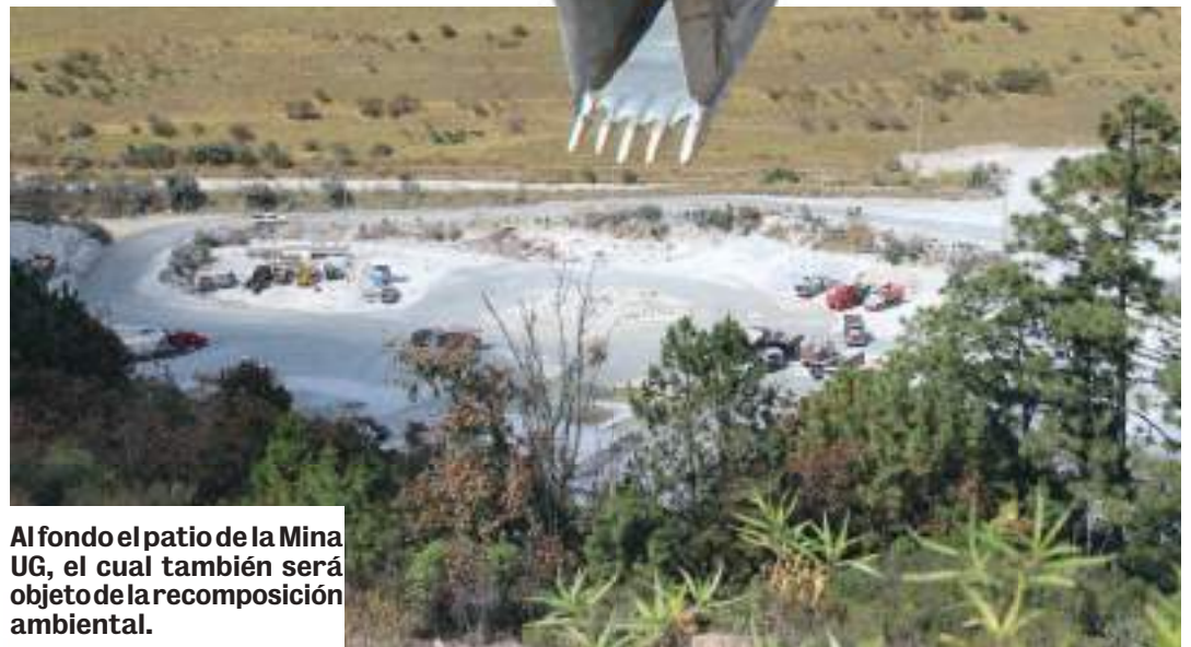
Se acarrean materiales que serán compactados para asegurar el suelo en La Escombrera.
