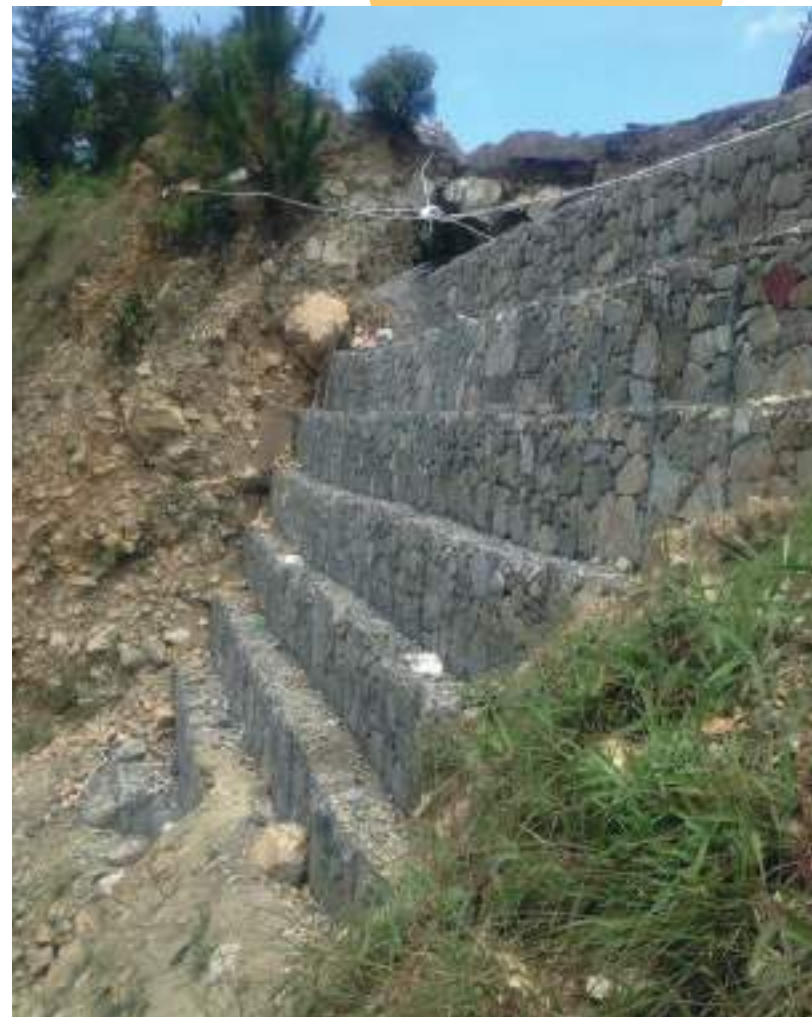
En alianza con la Alcaldía de San Miguel Ixtahuacán, se levantó un muro para detener erosión en carretera hacia Legal.
