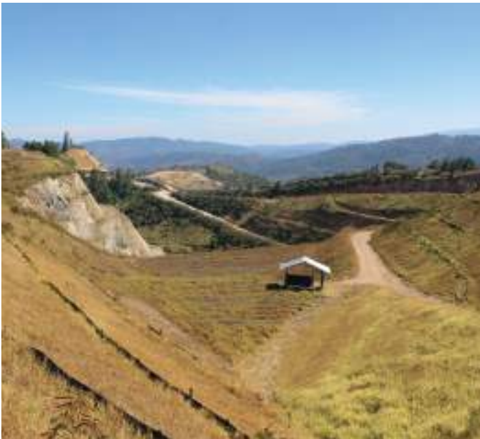
La revegetación se ha afianzado en el Tajo Cochise, donde las gramíneas han recubierto los suelos. En esta parte, la cumbre de lo que fue la mina a cielo abierto, se alista la siembra de arbustos, o sea para fortalecer el lugar previo a la plantación de árboles nativos.
