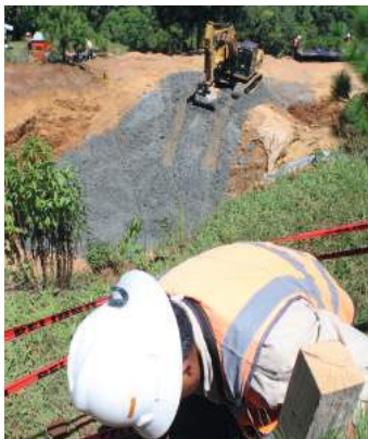
Los trabajos en el Sector Delmy fueron hechos bajo estrictas medidas de seguridad.
