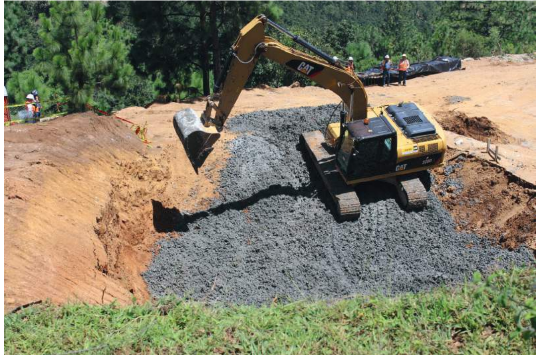
La maquinaria pesada de la Mina Marlin, bajo la dirección de los ingenieros de Obra Civil, fue utilizada para rellenar parte de las áreas intervenidas por la minería.
