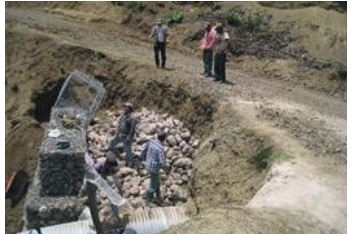
Construcción de muro en Tierra Blanca Múbil.
