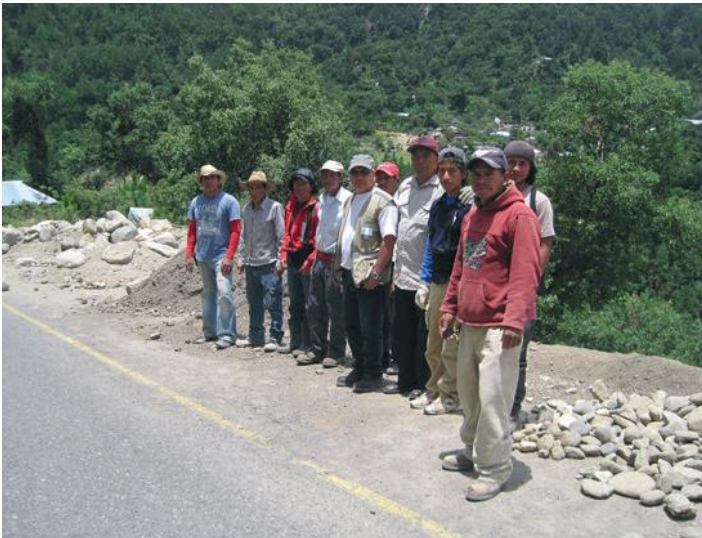
Fernando Gómez, de chaleco beige, en la construcción del muro de contención en la carretera hacia Legual.
