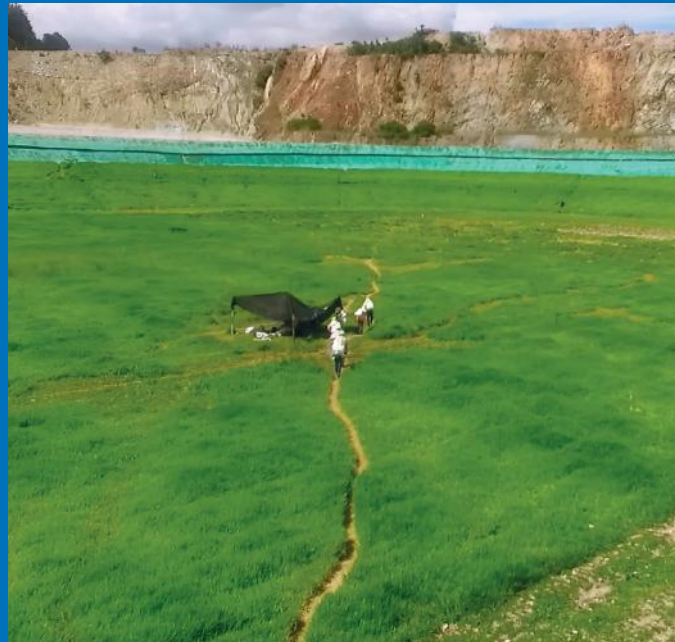
Después de la reconformación del Tajo Marlin y la siembra de grama, se procede a reforestar el área.
