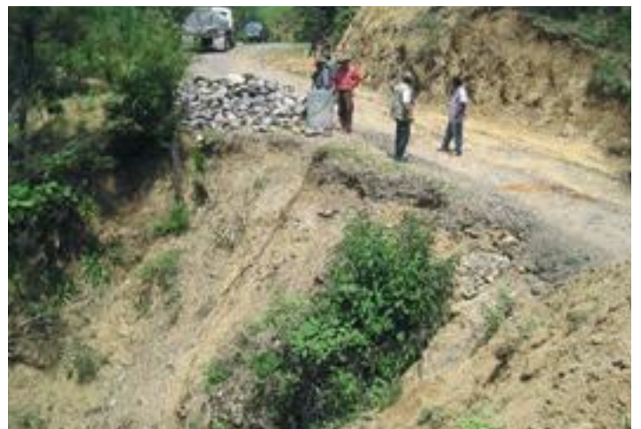
Trabajadores construyen el muro de contención en el camino que conduce de Ágel a Nueva Esperanza.
