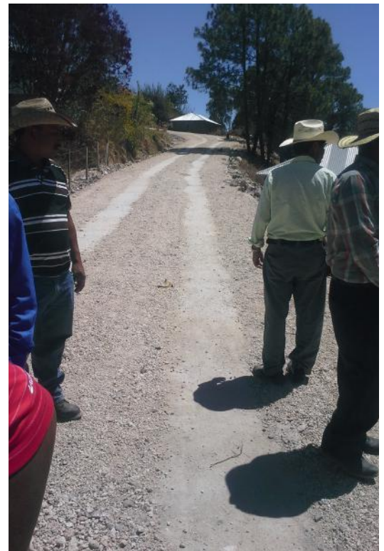
Con la instalación de las carrileras en El Salitre, se facilita el paso de vehículos livianos.
