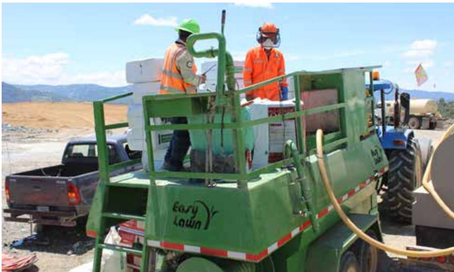
Con esta máquina se lleva a cabo el proceso de hidrosiembra. Se vierten sacos con fertilizantes, mulch y la semilla de grama que luego es esparcida a presión, por medio de un chorro de agua.
