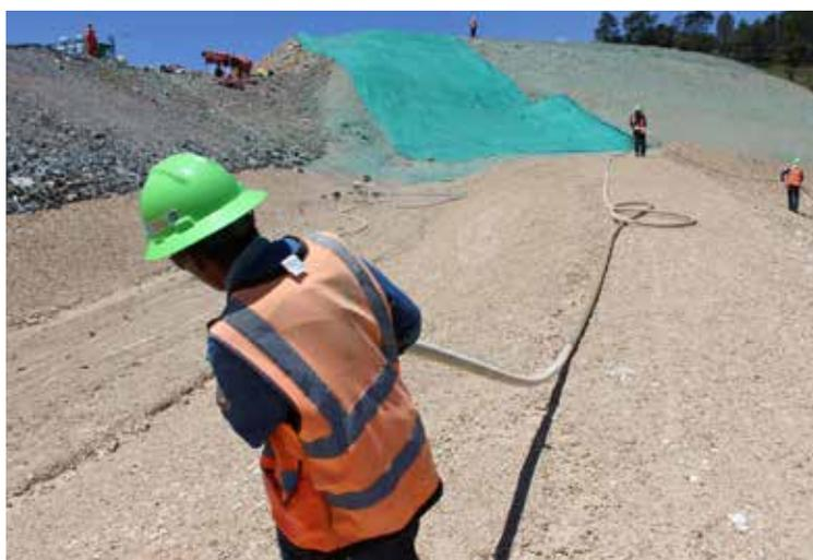
Después de conformados los taludes, se empieza el proceso de hidrosiembra, con el que se lanzan semillas de grama en las paredes desnudas.
