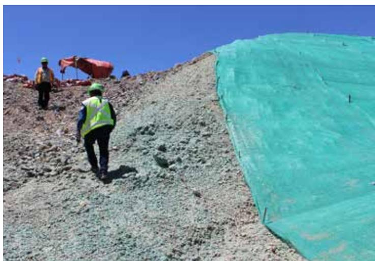
En el lado izquierdo se puede observar cómo quedan los taludes después de ser hidros sembrados. Posteriormente se les coloca ecomátrix como se observa en la derecha.
