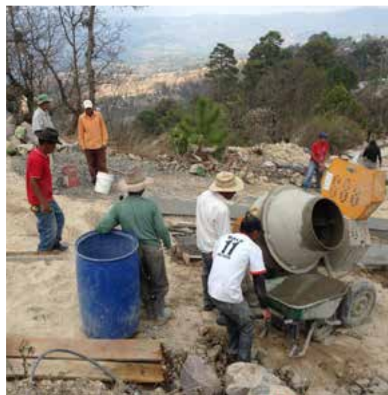
En la aldea El Salitre, trabajadores preparan la mezcla para rellenar las carrileras.
