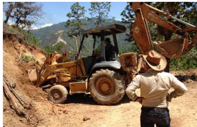
En el paraje Kiaqjul maquinaria rentada por la empresa minera amplía el camino de terracería.
