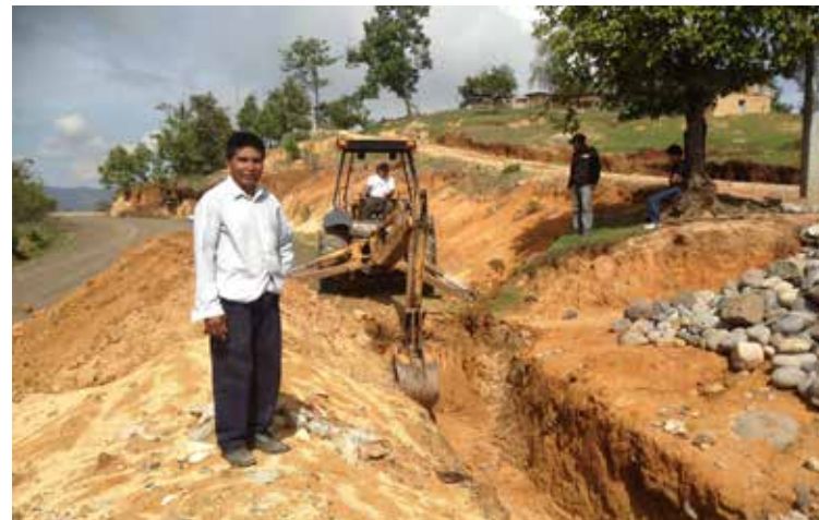
El presidente de Cocode de la aldea Ágel, Fernando Pérez, muestra la zanja que servirá para el drenaje del camino.
