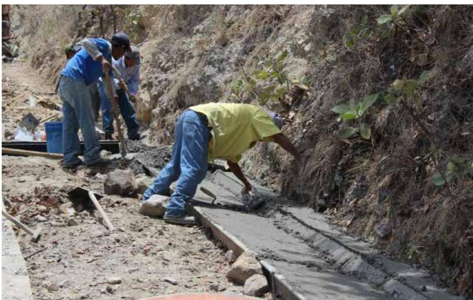
En algunas partes del tramo se construyeron cunetas de concreto.
