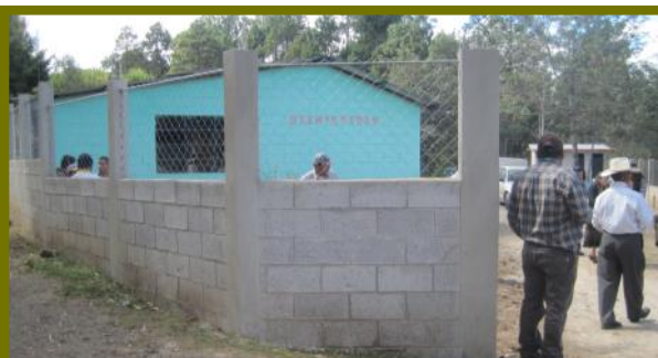
En el sector Matasanos se construyó un muro perimetral en la escuela de educación elemental, con lo cual se mejoró la seguridad de 63 estudiantes, dijo el director Víctor Manuel Trejo.
