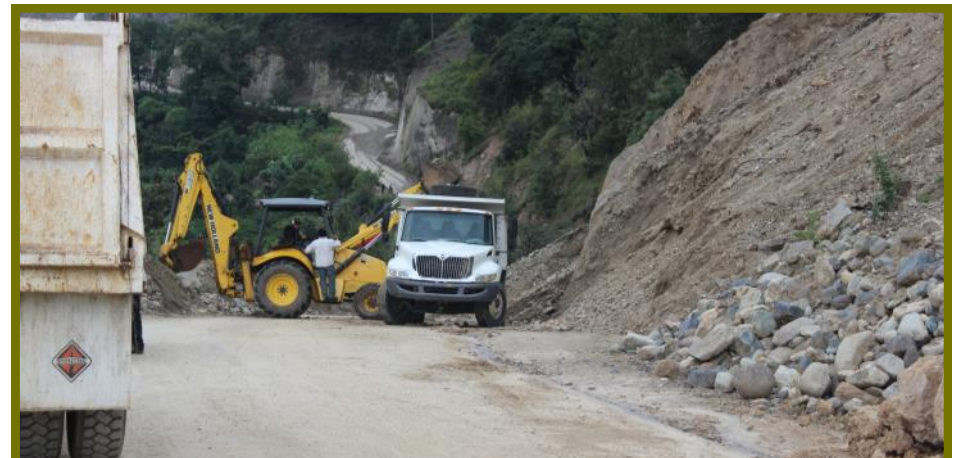
Los trabajos de mejoramiento carretero consistieron en el despeje y traslado de derrumbes, liberando así las vías de comunicación. Además se hizo limpieza de cunetas y pequeños deslaves.
