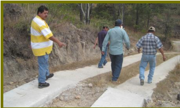
El sector Los Leones se construyeron 120 metros de carrileras para mejorar el ingreso a ese lugar. También una pared que circula la escuela primaria.
