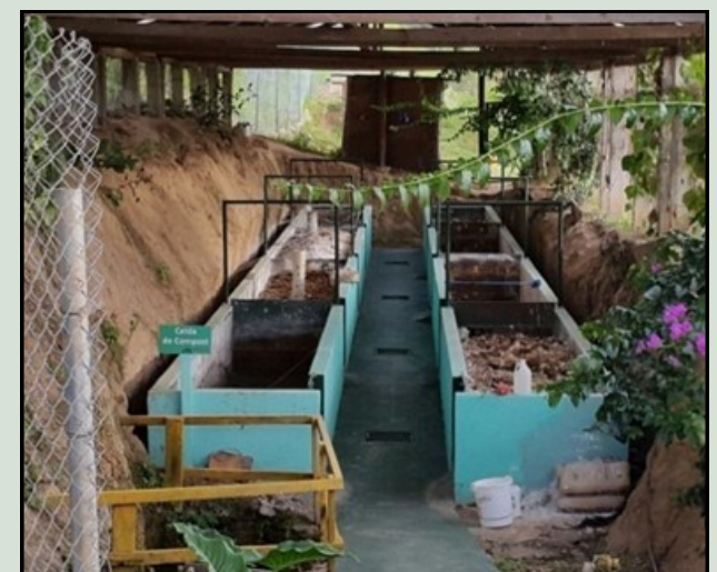
En las celdas de compostaje se hace el proceso de descomposición para la obtención de abono.
