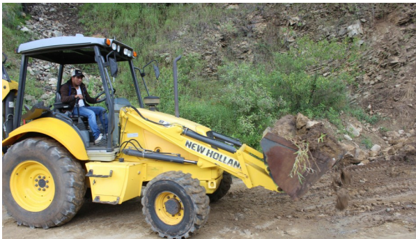
Maquinaria pesada despeja los derrumbes que obstruyen la carretera que conduce hacia Huehuetenango.
