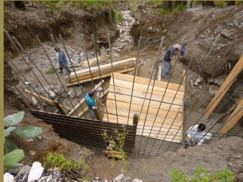
Construcción de la base de cimentación para un muro de contención en Sipacapa.
